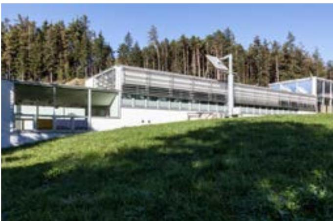
Abb. 4: Tageslichtsysteme mit Umlenkfunktion an der Fassade des Bartenbach F&E-Gebäudes, Aldrans. © Bartenbach, Foto: Peter Bartenbach
