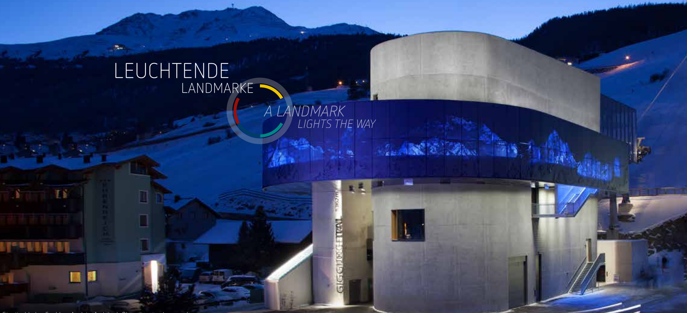
Gigijochbahn, Soelden, Austria, Architect: Obermoser arch-omo zt
